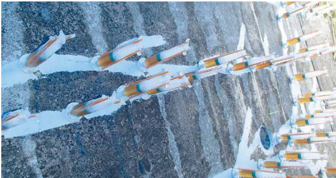
▲擁壁のひび割れ部へのリハビリボンド注入状況
