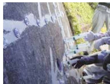
3.亜硝酸リチウム溶液の先行注入 (追加注入が可能)
