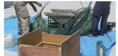
小規模工事ではコンクリートの揚重が大変
