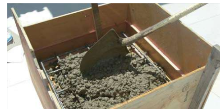
小規模工事の小型構造物では機械を用いた締固めが面倒
