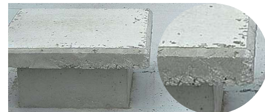
手直しが発生しやすい。更に頭部へアンカーボルト穴の穿孔が必要
