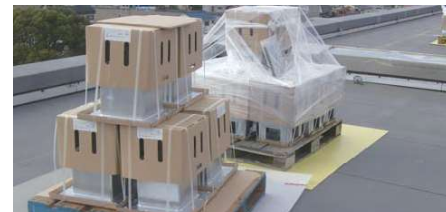
工場生産品を設置
