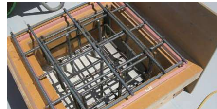
小規模工事では鉄筋工、型わく工を集めるのが大変
