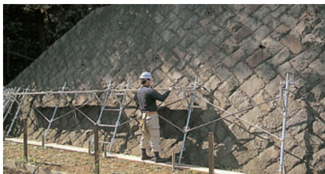
②鋼製布板設置
