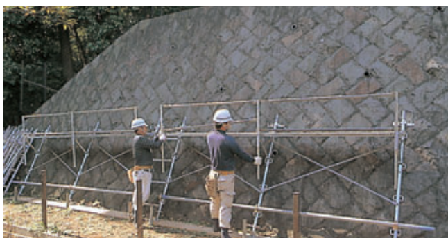
③伸縮手すり設置
