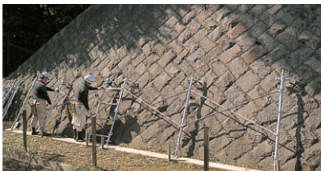
①のり支柱設置
