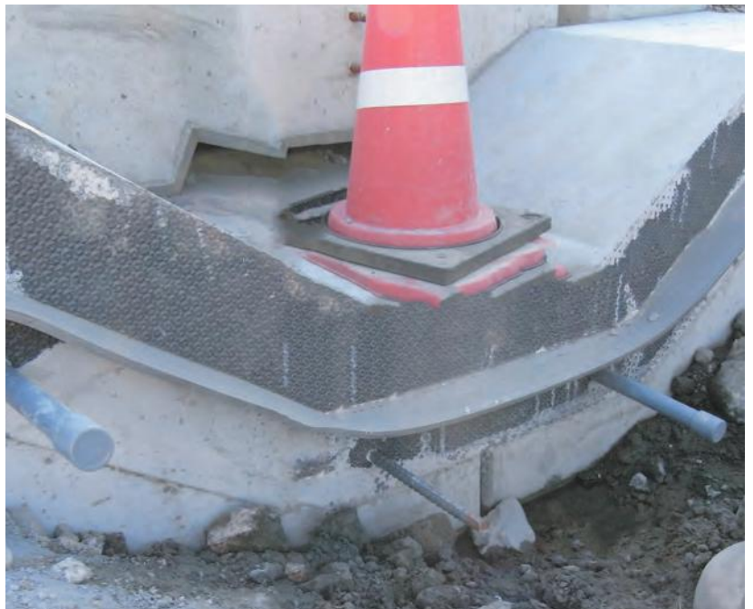
▲ダウエルバー設置状況
