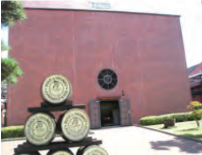
外壁タイルの補修保護工事
