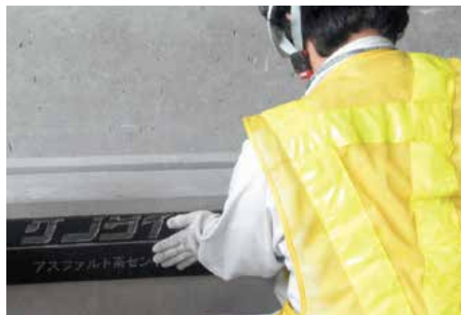
▲ケンタイト貼り付け状況
