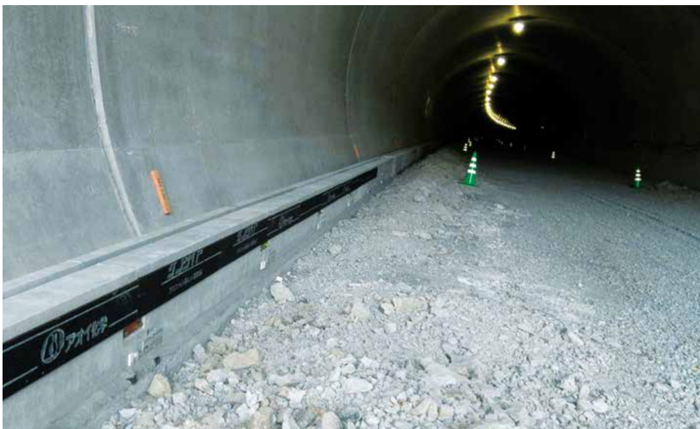
▲コンクリート舗装側目地の目地板（ケンタイト）仮固定に使用
