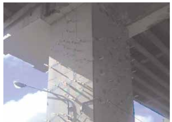
▲CRBインジェクターを用いた注入補修状況
