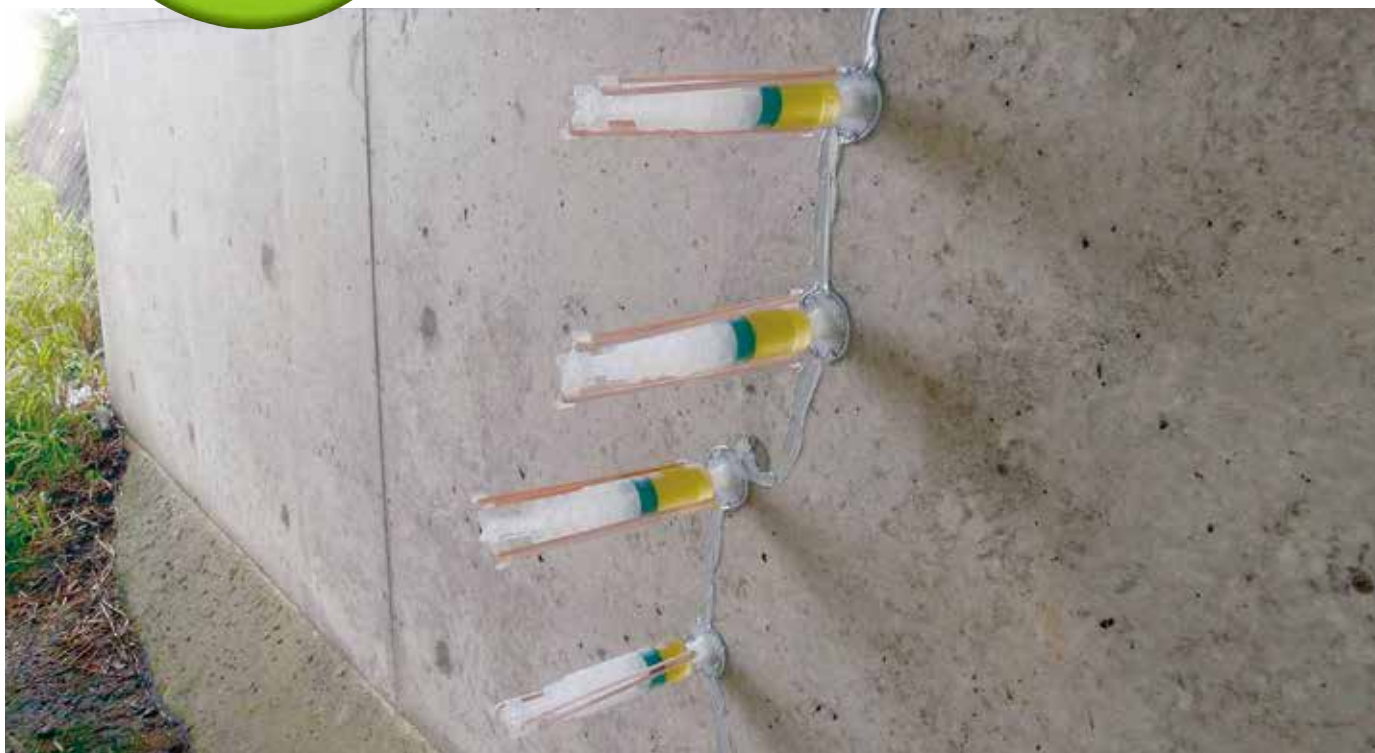
▲CRBインジェクターを用いた注入補修状況
